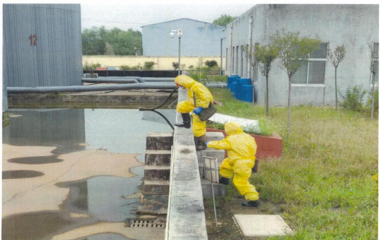
冲洗组两名员工立即穿戴好防护服从东门口室内消防箱内拿出备用消防水带，连接好消防栓，一人接上消防水枪后扯到泄漏点，另一人打开消防栓，消防水冲洗泄露点。
