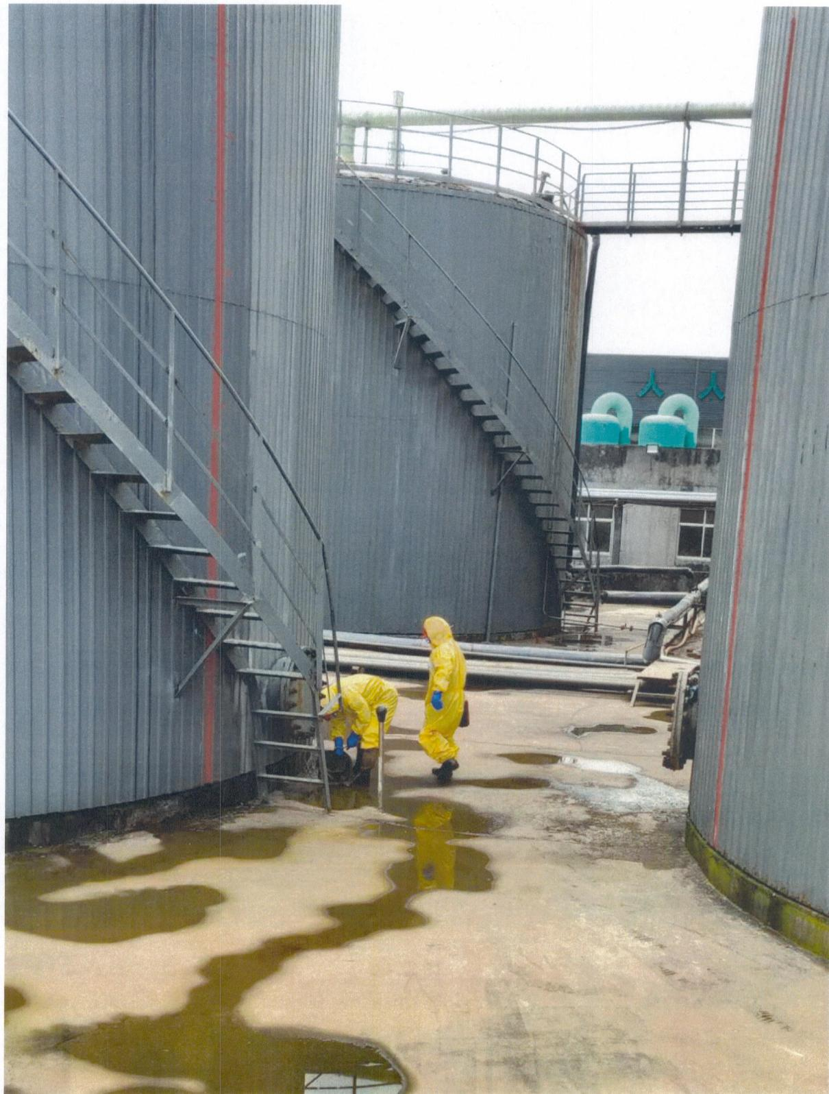
经现场检查，发现阀门处泄露，对阀门紧固后不再泄露。
